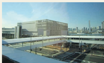
Il nuovo mercato di Toyosu ha scatenato seri dubbi sulla sicurezza
