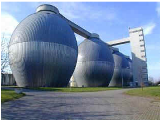
Foto 2-2: Impianto di trasformazione senza ossigeno
